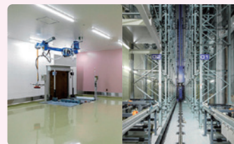
常温自動倉庫の内部
