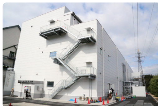
京都工場7号棟外観
