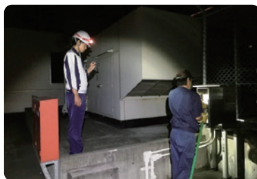
夜間に非常用発電機の運転に必要な燃料を夜間に給油している様子。停電により外灯が消えているため、ヘッドライトの明かりを頼りに給油を繰り返し、非常用発電機の運転を継続していた。
