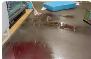
凝固棟2F機械室 プライン配管の 破損により液体が漏出していた。
