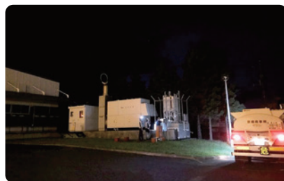
夜間に非常用発電機の運転に必要な燃料を夜間に給油している様子。停電により外灯が消えているため、ヘッドライトの明かりを頼りに給油を繰り返し、非常用発電機の運転を継続していた。
